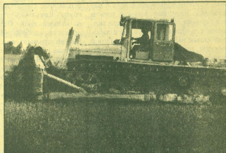
На этом бульдозере ДЭТ-250 седьмого июля 1974 года машинисты бульдозера И. Кривонос и А. Безруков начали убирать плодородный слой земли на том месте, где сегодня находится центр разреза “Березовский - 1”.
